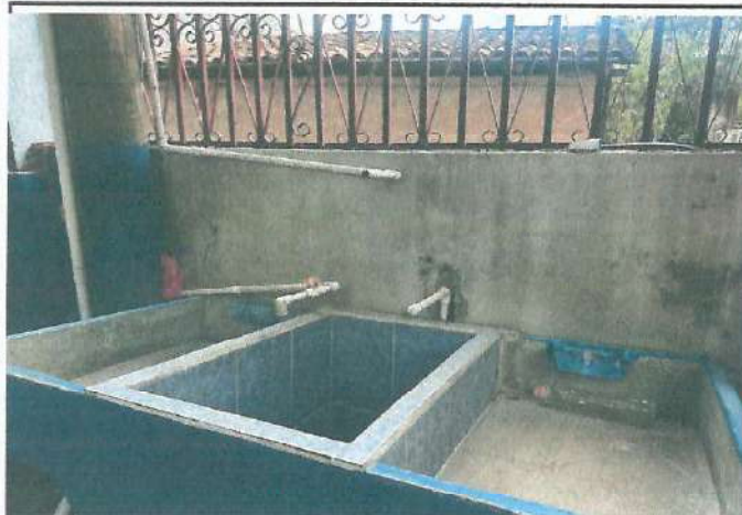
Foto 1: AREA DONDE SE CONTEMPLA REPARAR LA RED DE DISTRIBUCIÓN DE AGUA
