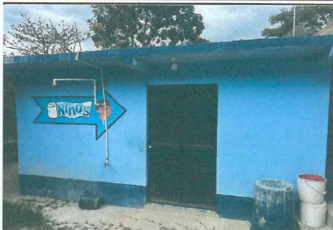
Foto 2: OTRO ESPACIO DONDE SE CONTEMPLA REPARAR LA RED DE DISTRIBUCION DE AGUA
